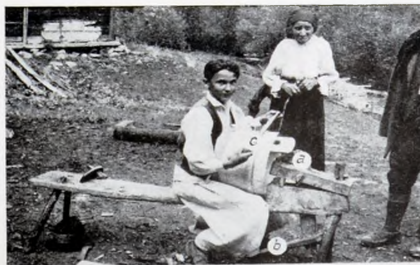
3. SCAUN DE CUȚITOAT din Gîrda de Sus, punctul 95 (harta 556) a) CAP (harta 557) b) TĂLPIG (harta 558) c) LAMĂ LA CUȚITOAIA DULGHERULUI (harta 555)
